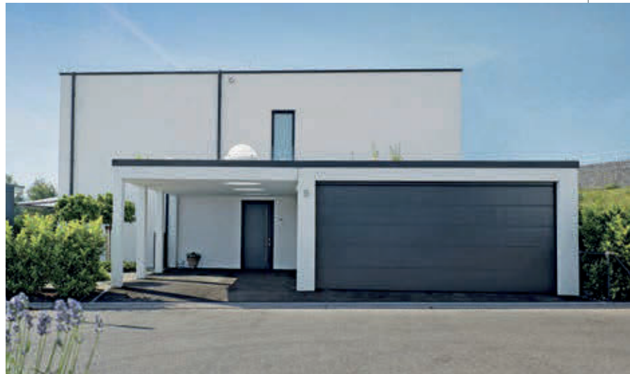
Der Hauseingang ist wettergeschützt und ebenerdig erreichbar.
